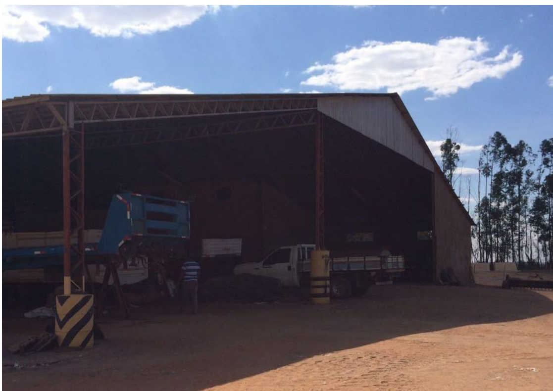
Anexo 7: Barracão de máquinas da Fazenda Dois Amigos
