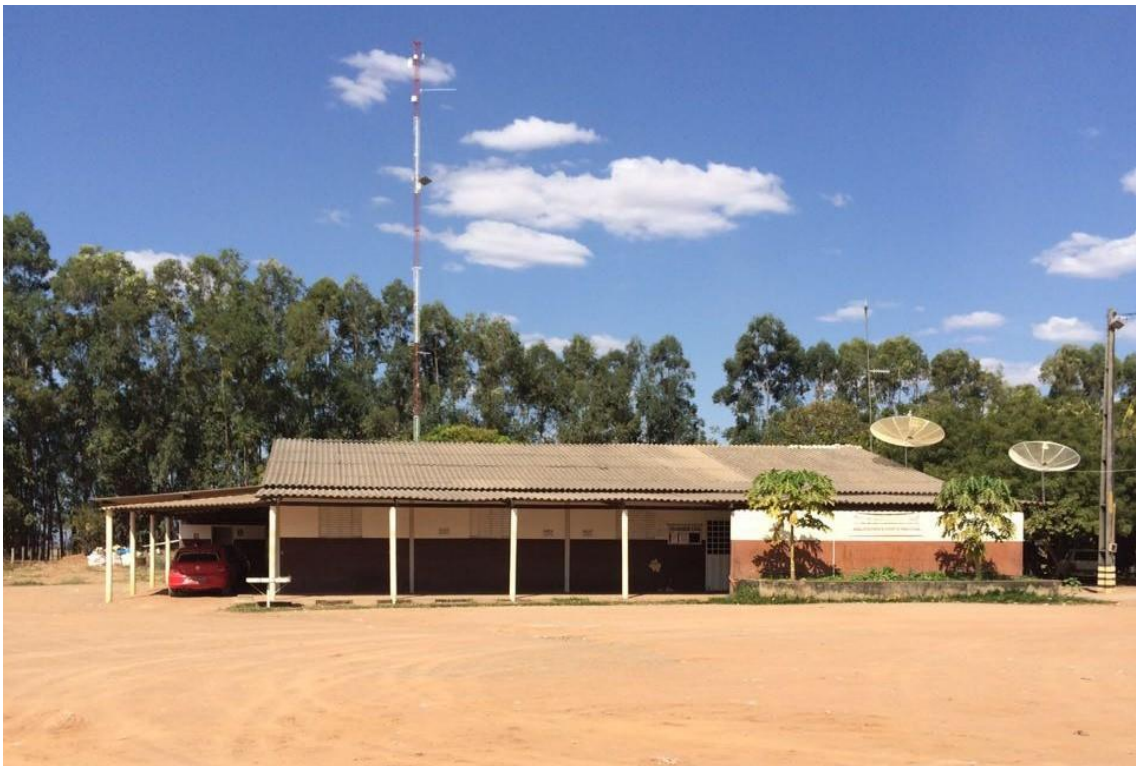
Anexo 11: Alojamento e cantina da Fazenda Dois Amigos Fonte: Arquivo Pessoal
