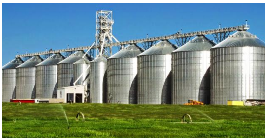
Figura 3. Bateria de silos verticais em chapa metálica. Fonte: Google imagens, 2018.
