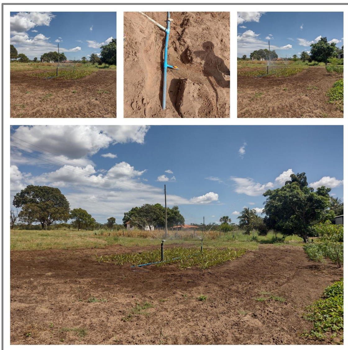
Figura 3. Instalação da irrigação.
